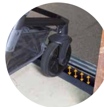
Desnivel entre cabina y el suelo
